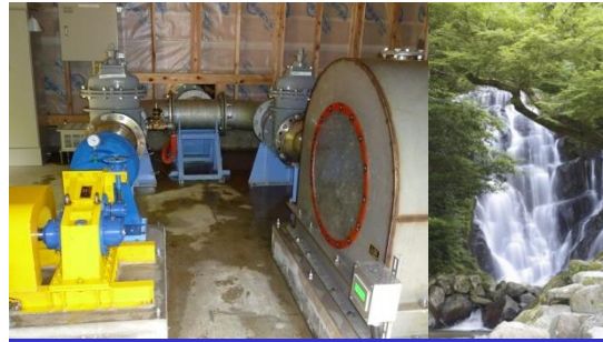
白糸の滝 小水力発電所
