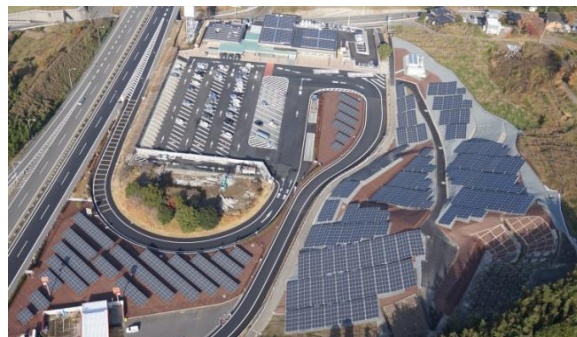
大分自動車道 山田SA 太陽光発電所
